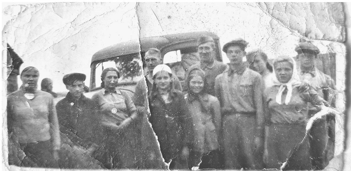
Жители д. Милодеж на строительстве дороги у д. Вяжищи, лето 1942 года
