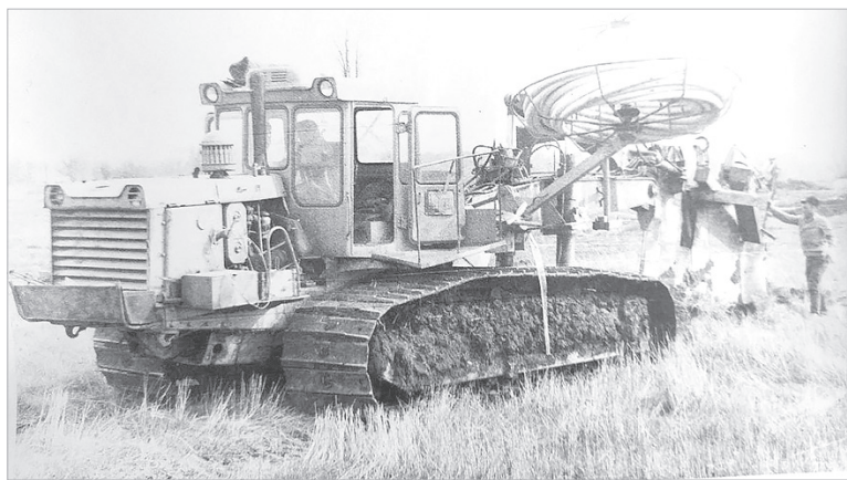
Укладка дренажа бестраншейным способом
