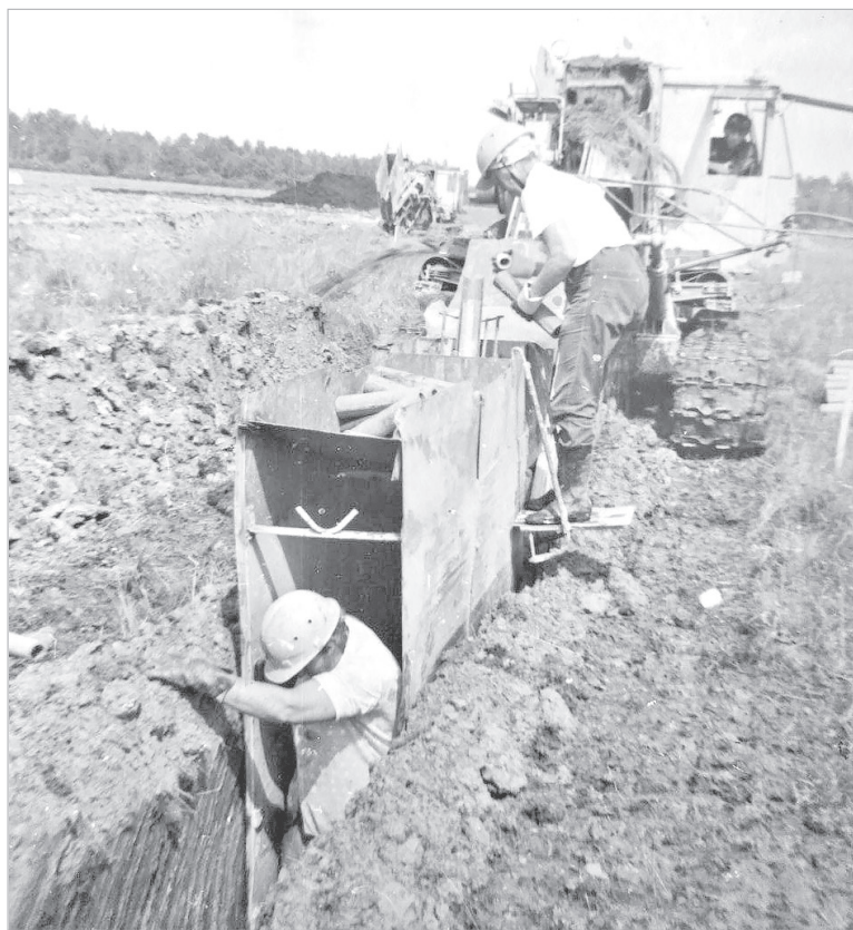
Женщины на строительстве дренажа
