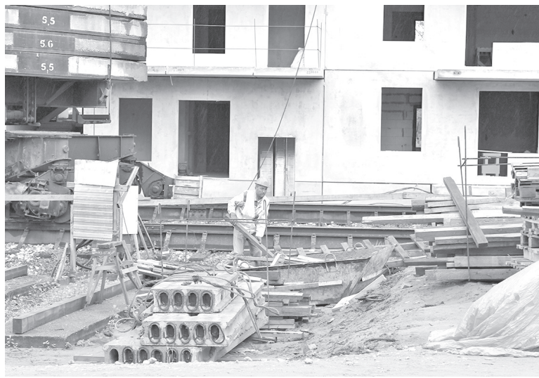
📷 Строительные работы в разгаре
