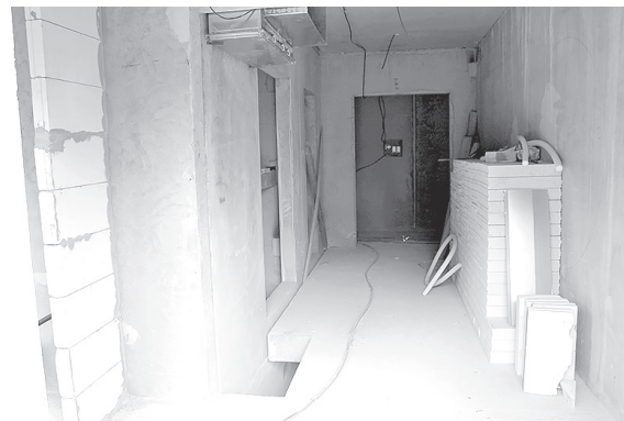
📷 Лифтовое помещение. Шахта лифта пока пуста
