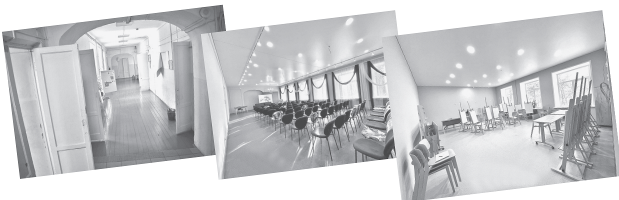
Идет капитальный ремонт детской художественной школы
