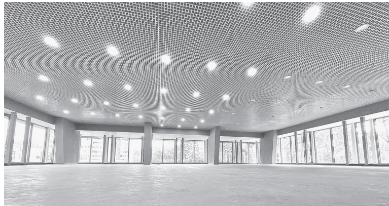
■ Идет ремонт Лужской межпоселенческой районной библиотеки
