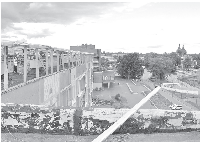
📍 Идут работы по замене кровли на доме № 1 по ул. Набережной
