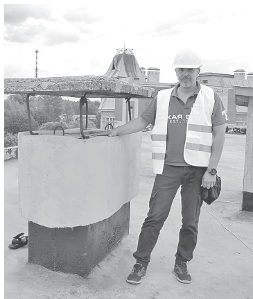
📍 Сергей Грицаенко: «Сделали вентиляционные шахты. Потом их накроют специальным металлическим колпаком для защиты от осадков»
