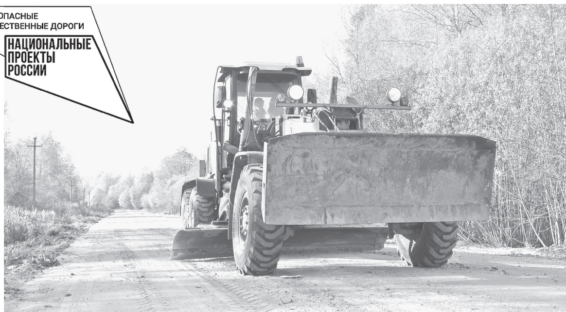
■ Планировка проезжей части гравийной дороги Заполье – Сырец – Щепы автогрейдером. За рулем – опытный машинист Александр Михайлович Павлов, отработавший в ДРСУ более 30 лет, гордость предприятия
