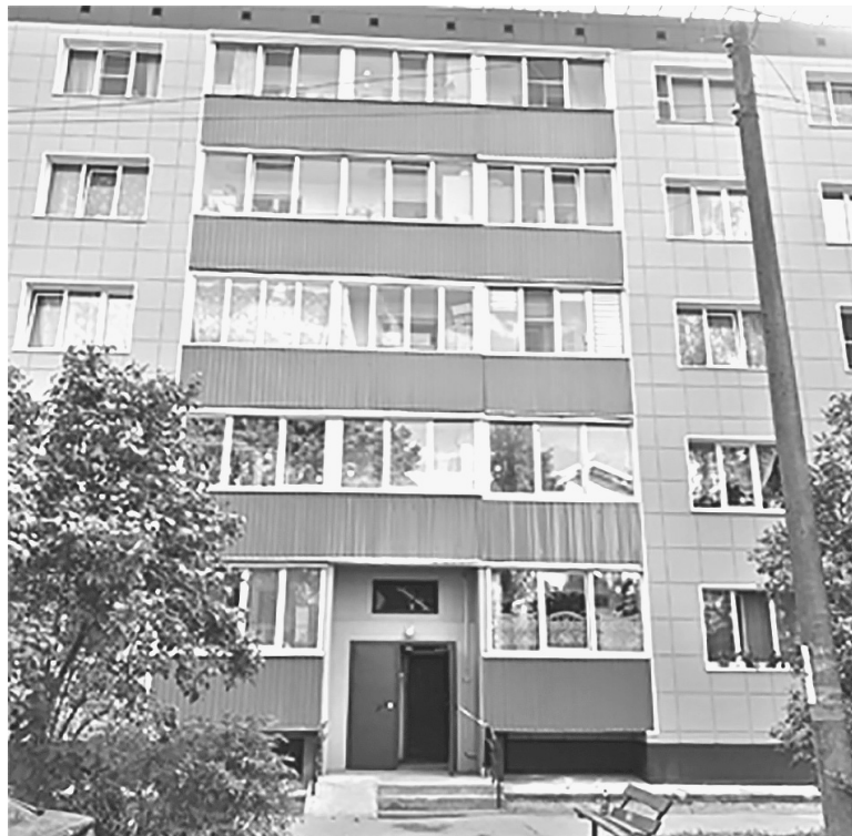
После завершения работ
