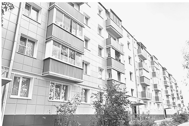
После завершения работ
