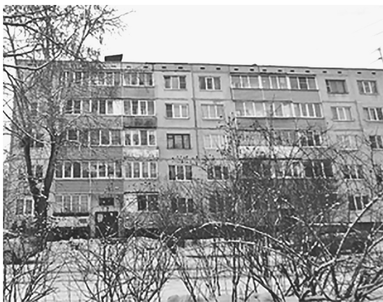
До начала работ
