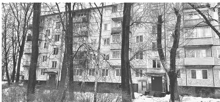
До начала работ
