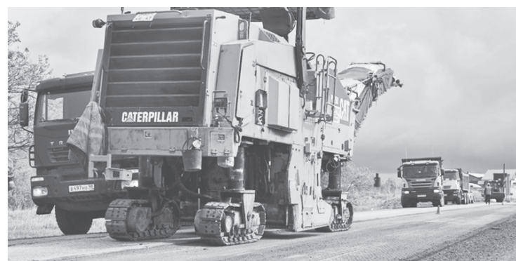
Дорожные работы на региональной трассе Лодейное Поле — Тихвин — Будогощь в Тихвинском районе
