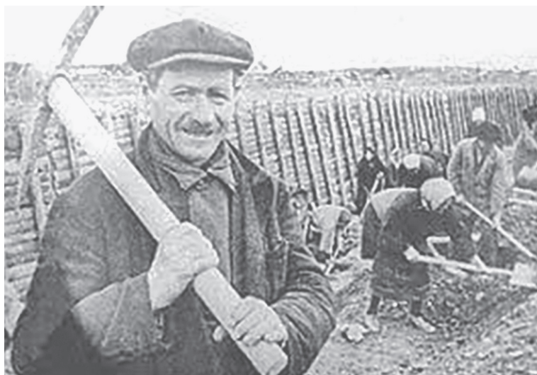
☛ На строительстве противотанковых рвов
