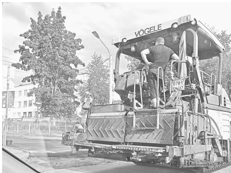
Дорожная техника на улице Болотной
