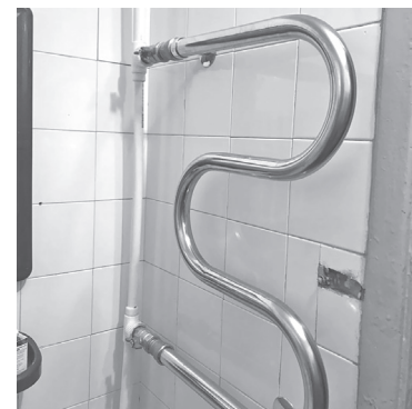
📷 Установлен новый полотенцесушитель в квартире
