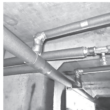
📷 Новые сети холодного и горячего водоснабжения
