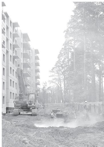
📍 На территории вокруг домов прокладываются инженерные сети: тепловые, ливневой и хозяйственно-бытовой канализации, водопровода, электрические – монтируется оборудование для электроснабжения домов и наружного освещения
