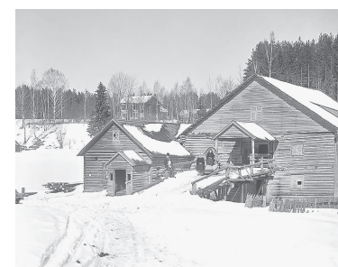
Имение Штоля. Начало XX в. Фото С.М. Прокудина-Горского
