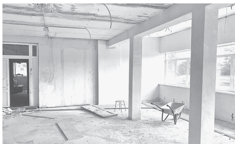
📷 Идет ремонт в Доме культуры
