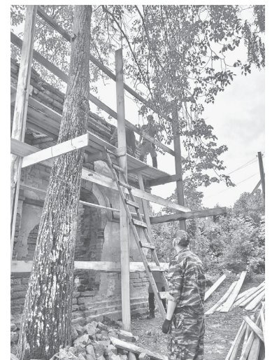
Установка строительных лесов на фасаде Георгиевской часовни
