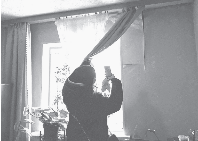
■ Жилищный инспектор А.О. Колодяжная фиксирует повреждения в квартире
