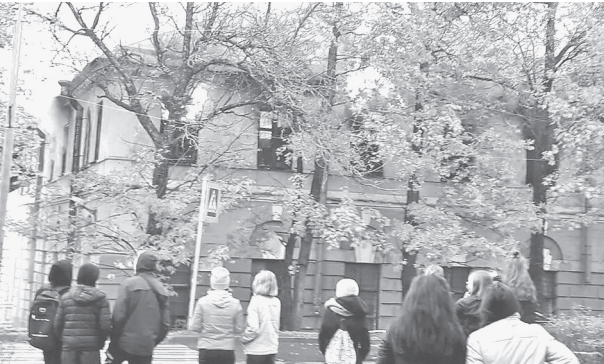
📷 28 сентября пожарные вновь тушили огонь в бывшем здании милиции
