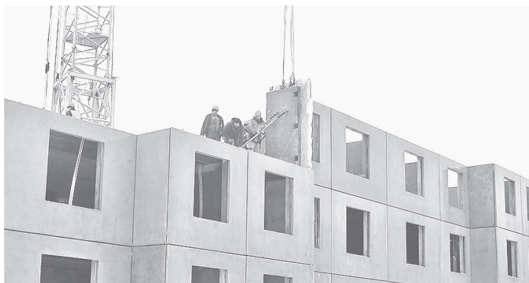
📷 Монтаж стеновых панелей. Они толщиной 340-380 мм с утеплителем посередине – в квартирах будет звуко- и теплоизоляция. На односекционном доме возводится третий этаж.
