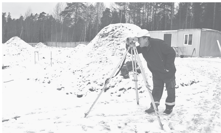
📷 Ш.И. Ибрагимов делает контроль высотных отметок
