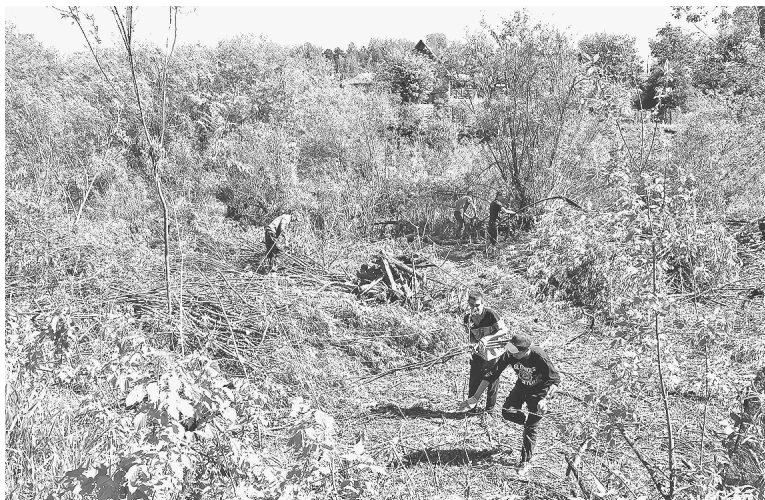
■ Начались работы на еще одном участке набережной реки Луги. Проведена расчистка территории
