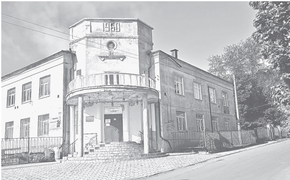
Здание на месте школы
