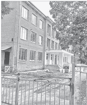
Идет ремонт начальной школы № 3
